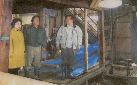
柱や土台がむき出しになった現場で工事担当者 と打ち合わせする東亮一さん(中央)と八重子 さん(左)＝小千谷市元町の割烹「東忠」
